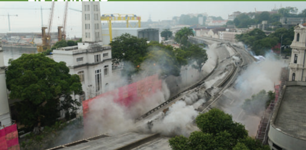
Fabio Bruno Construções utilizó cuatro tipos de demolición para el proyecto.
