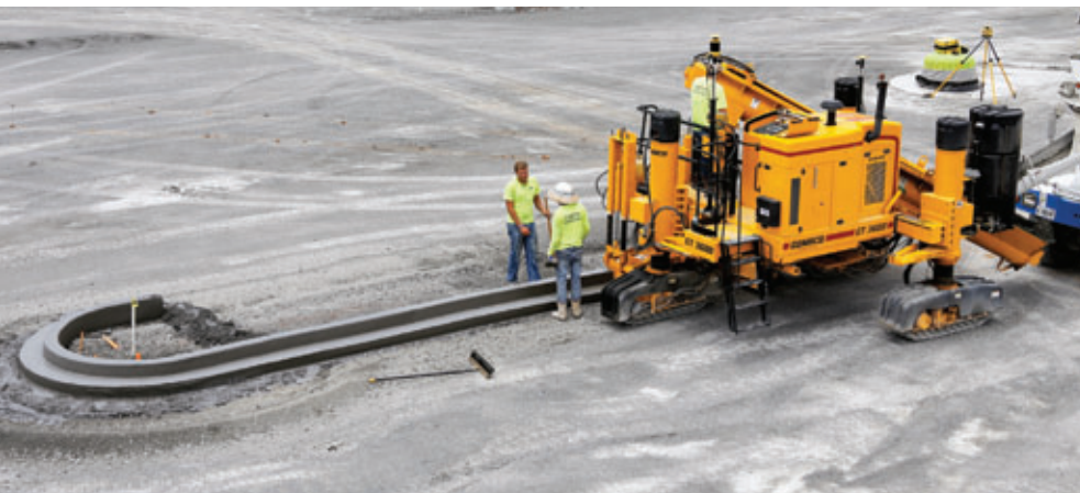
Gomaco exhibió su pavimentadora GT 3600.
