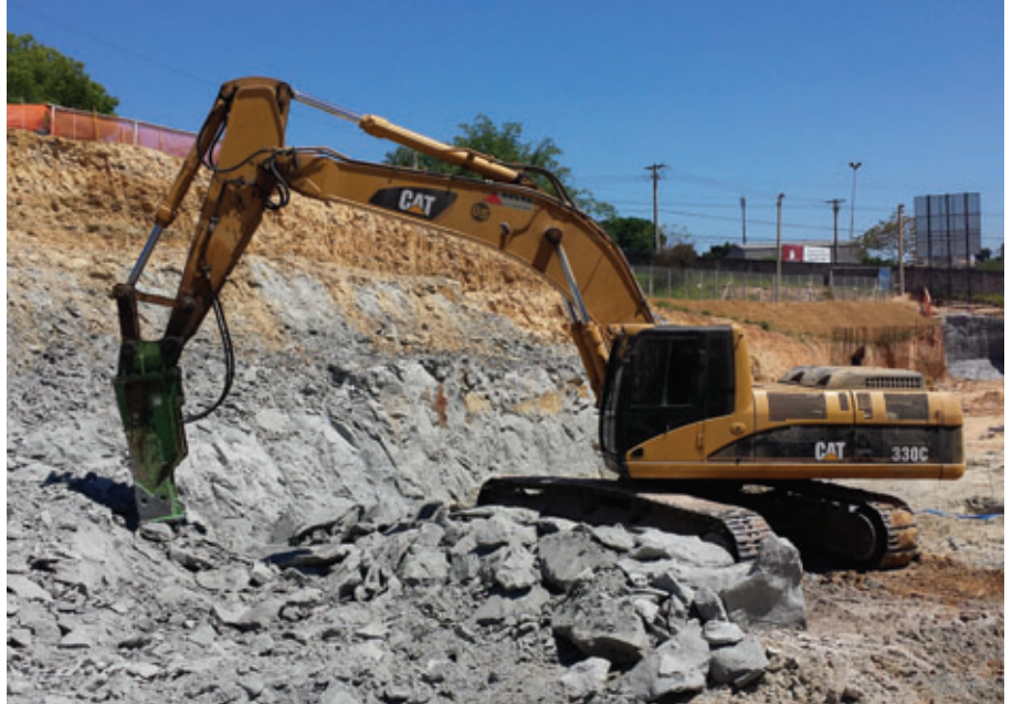
La retirada de arenisca para la construcción de un centro comercial por la empresa Delta fue asesorada por Maxter, que proveyó los martillos All Work.
