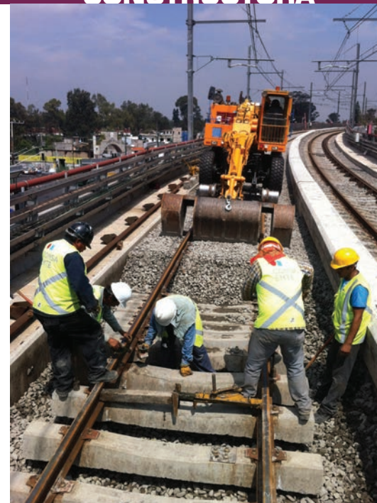
Rehabilitación y mantenimiento de la línea L12 del metro de Ciudad de México.
