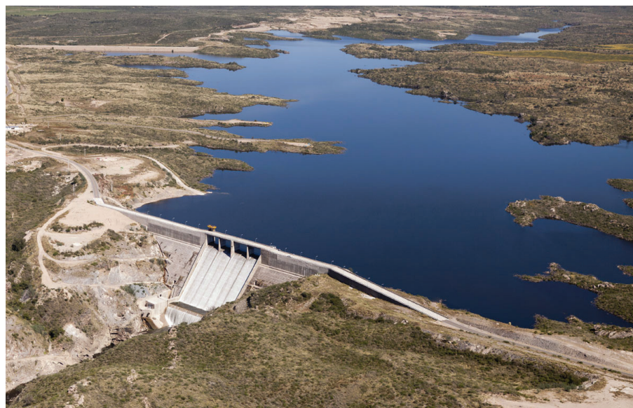
Presa sobre Rio Quinto, provincia de San Luis. Obra finalizada en 2011.
