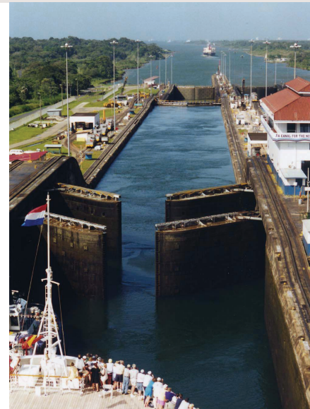
Las obras fueron paralizadas por el consorcio a cargo del proyecto el 5 de febrero.
