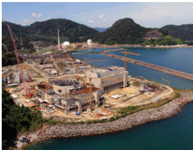
Las obras de la planta nuclear están paralizada desde hace meses.
