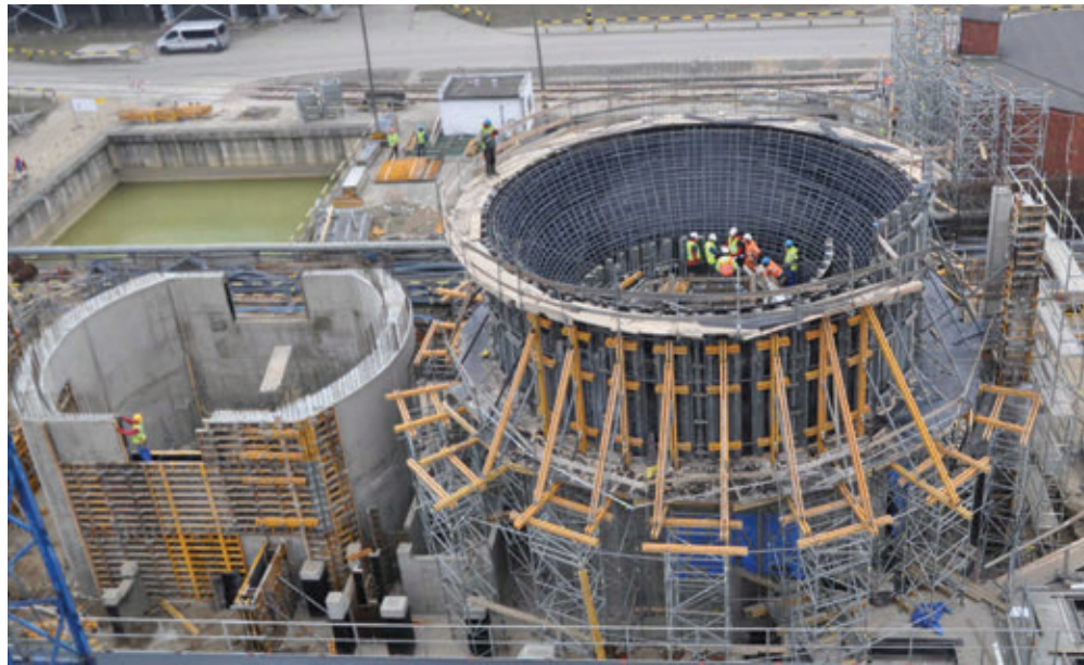
El nuevo sistema Biramax de Ulma está pensado para estructuras curvas con radio mínimo de 2 metros.
