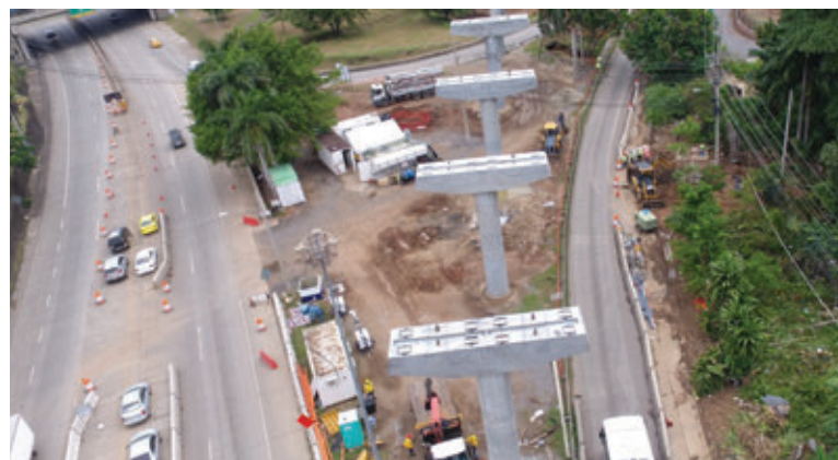
Según informó el consorcio formado por Odebrecht y FCC, a mediados de agosto comenzó el proceso de instalación de las vigas tipo U.
