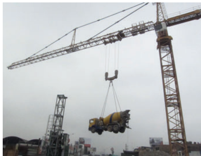
Dos grúas torre 550EC-H 40 Litronic trabajan en la nueva línea del Metro 2 de la capital peruana
