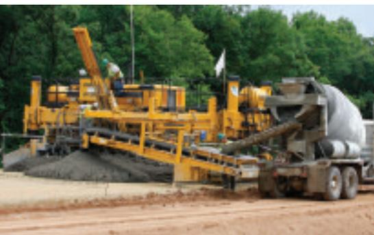
**La pavimentadora GP-2600 de GOMACO, pavimenta hasta 9,75 metros de ancho, y es impulsada por un motor diésel de 205 kilovatios.**
