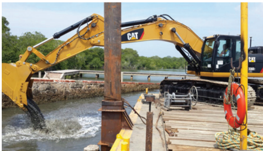
Obras de protección costera, en Cartagena de Indias.
