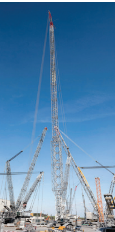
Con el sistema SX se pueden elevar componentes de hasta 120 toneladas.
