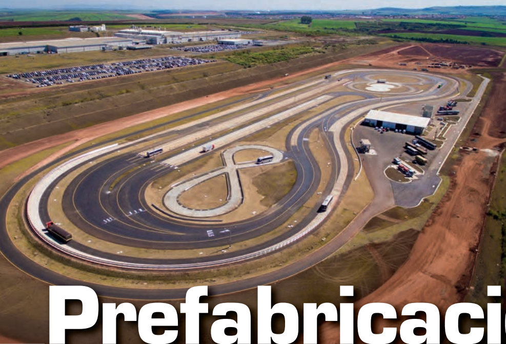
Pista de pruebas de camiones de Mercedes-Benz en Brasil, hecha con prefabricados de concreto de Leonardi.
