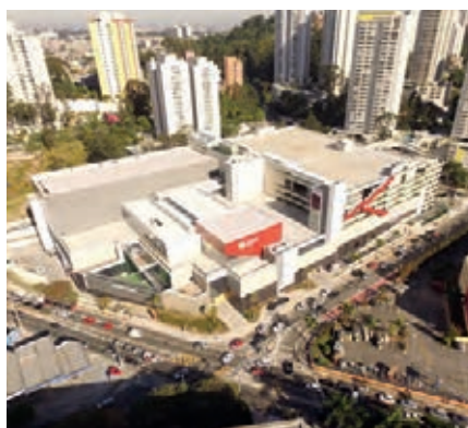
El centro comercial Morumbi Shopping, en São Paulo, utilizó 6.500 m³ de concreto en piezas prefabricadas.
