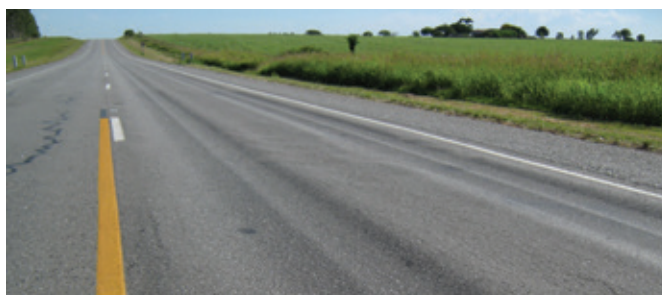
El préstamo se utilizará para obras de rehabilitación y mantenimiento en las rutas 21 y 24.
